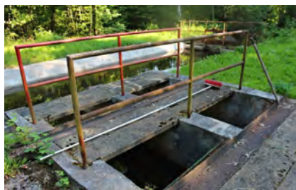
Úpravna vody ve Velcí.
