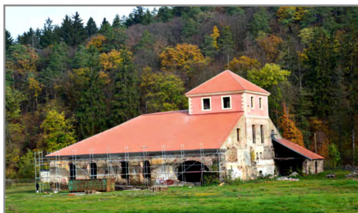
Unikátní dřevouhelná huť Barbora v průběhu rekonstrukce.
